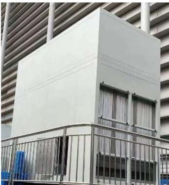
一体化蒸发冷却高效集成冷站
