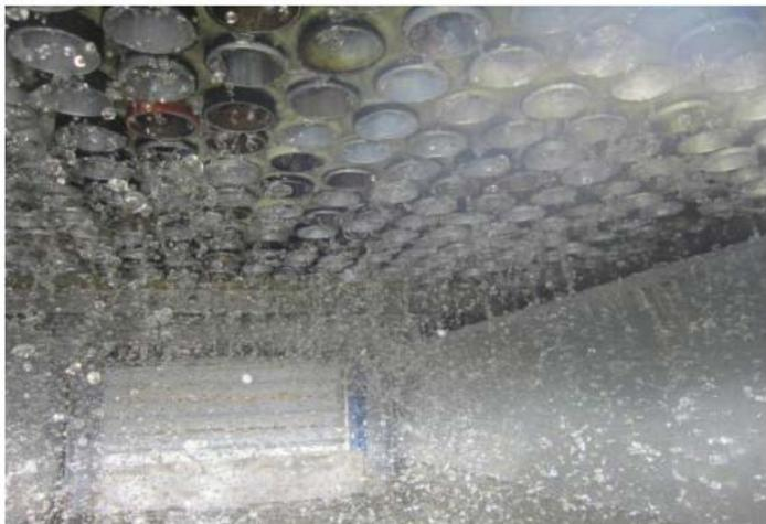
立管式间接蒸发冷却器换热管内落水图
