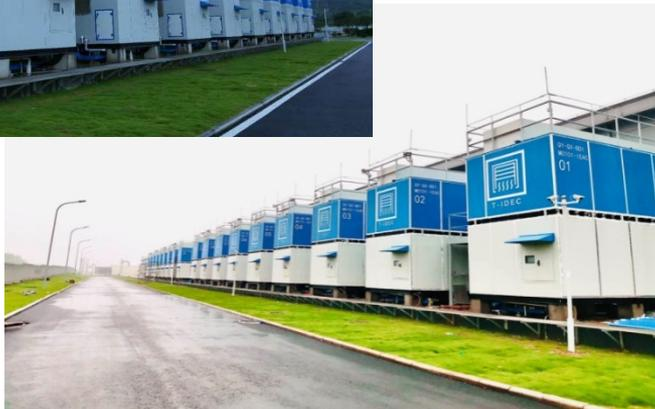
间接蒸发冷空调等T-block技术，实现像乐高搭积木一样快速建设的同时，进一步提升自动化高效运营。
