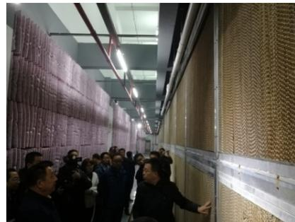
蒸发冷却器与建筑物土建结构紧密结合，空调系统与建筑物融为一体，利用建筑结构作为风道，这样可大大节约空调设备占据的机房空间。
