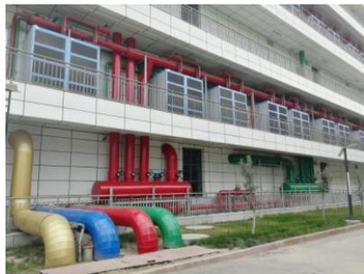
某数据中心蒸发冷却空气—水空调系统节能效果显著
